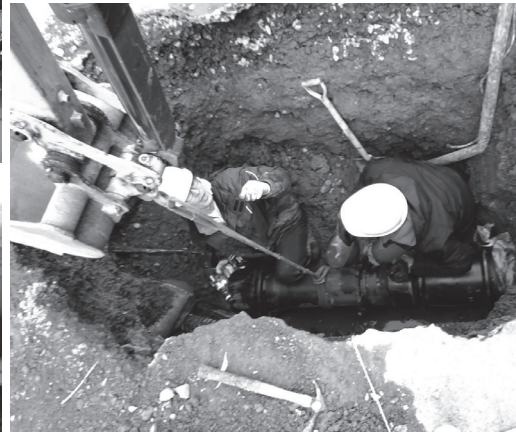
水道管復旧状況(ダクタイル鋳鉄管)
