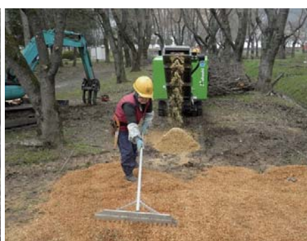
現場に運んで粉碎でき、そのまま敷いていける。
