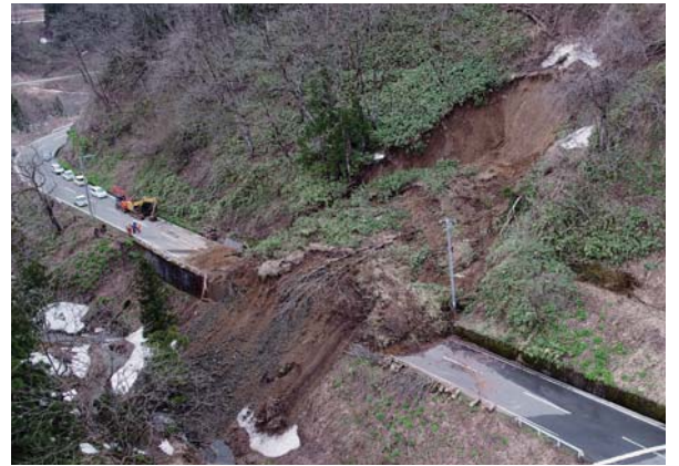
人が立ち入れない危険な現場でも上空から全体を把握できる
