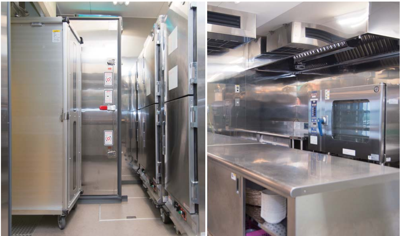
冷たい料理はカートに入れてそのまま大型冷蔵庫に、温かい料理はホットワゴンに。スチームコンベクションオープン、皿を温めておく保温機。
